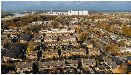
Figuur 1-3: renovatie en verduurzaming 79 woningen Schildersbuurt in Hoogkerk (bron: Wierden en Borgen)
